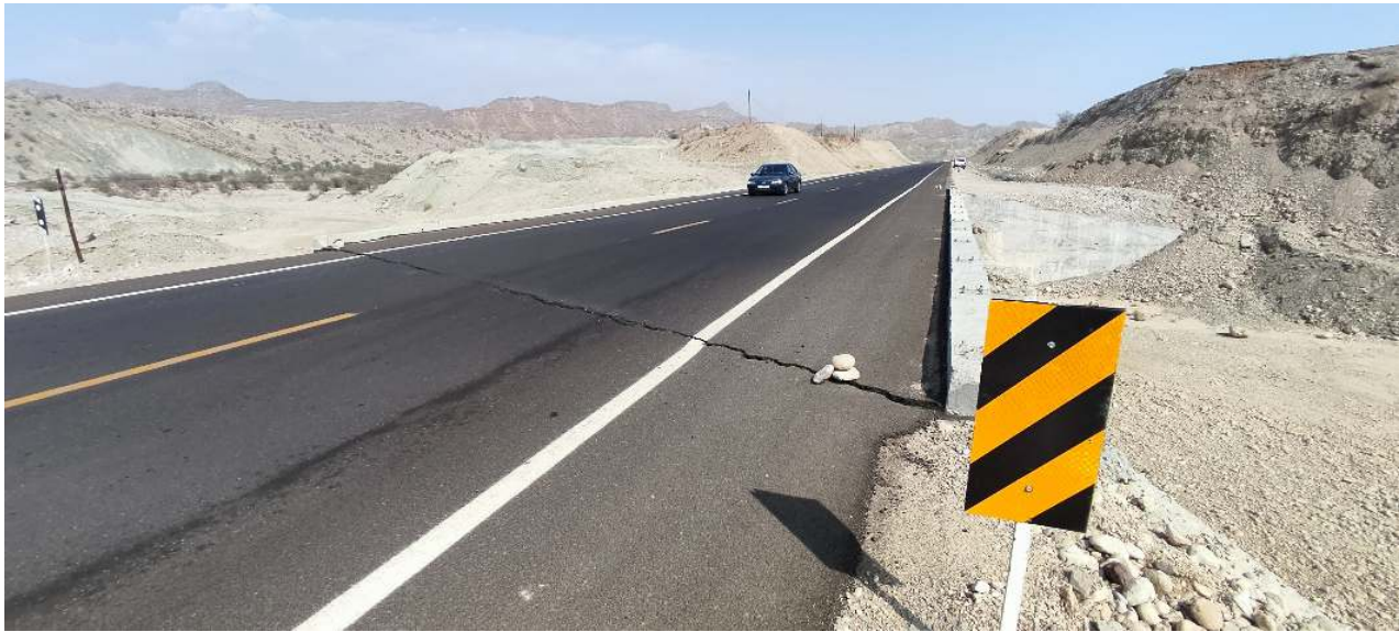
تصویر ۹۶ جابجایی پل در محل درز انقطاع در ۳ کیلومتر جاده سیاهو
