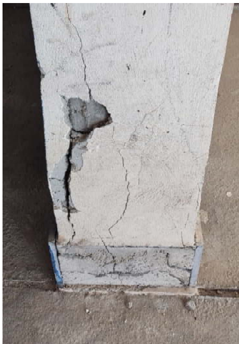
تصویر ۵۶ خوردگی ستون‌های بتنی و فونداسیون سازه به دلیل بالا بودن سطح آب زیرزمینی در بندرعباس
