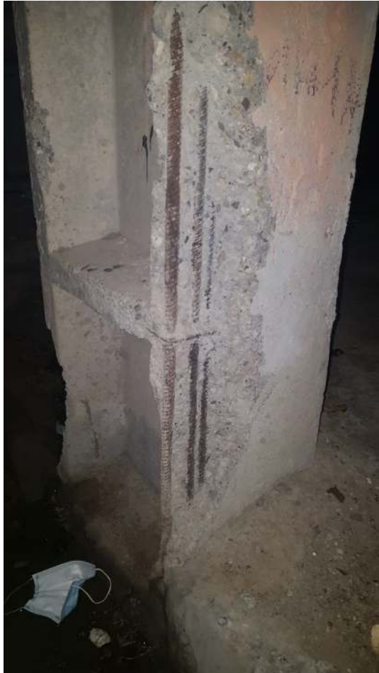
تصویر ۵۲ خوردگی آرماتور پای تیر برق در بافت فرسوده و محلات شهر بندرعباس
