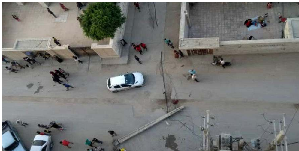
تصویر ۱۰۵ سقوط تیر برق در معابر عمومی، قطعی برق منطقه
