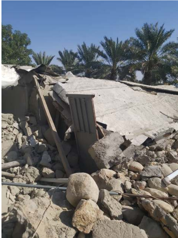
تصویر ۳۱ ریزش دیوار و سقف خانه‌های خشتی و گلی در روستای مزرا
