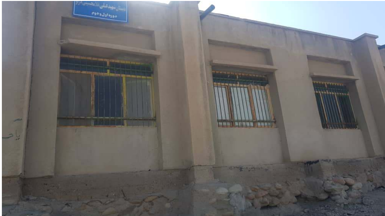
تصویر ۴۰ عدم ایجاد ترک خوردگی و خسارت در دبستان روستای ذرتو
