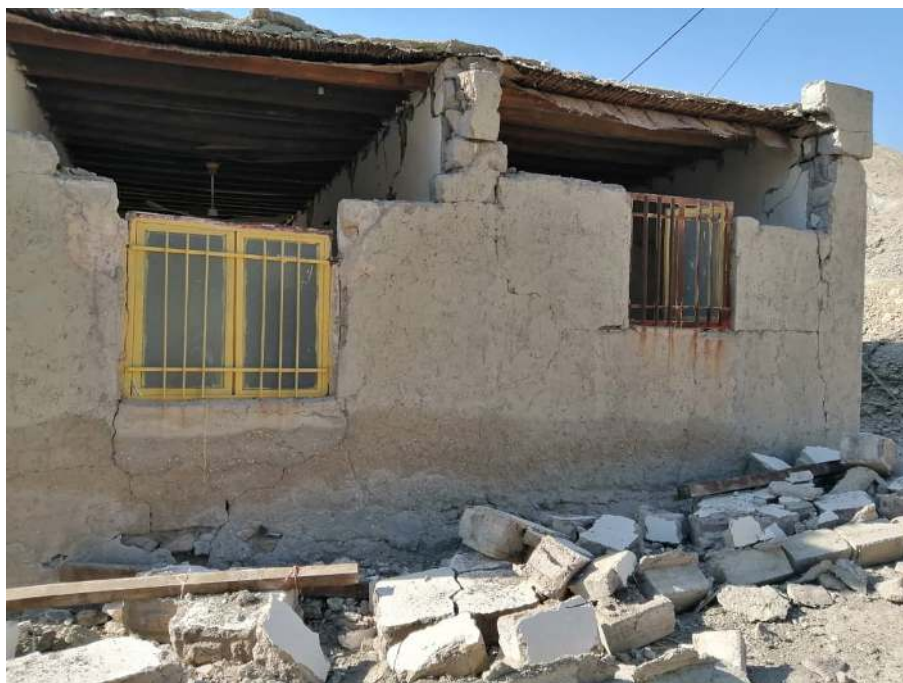
تصویر ۲۸ ریزش ساختمان‌های با دیوارهای سنگی و سقف چوبی در روستای مژرا
