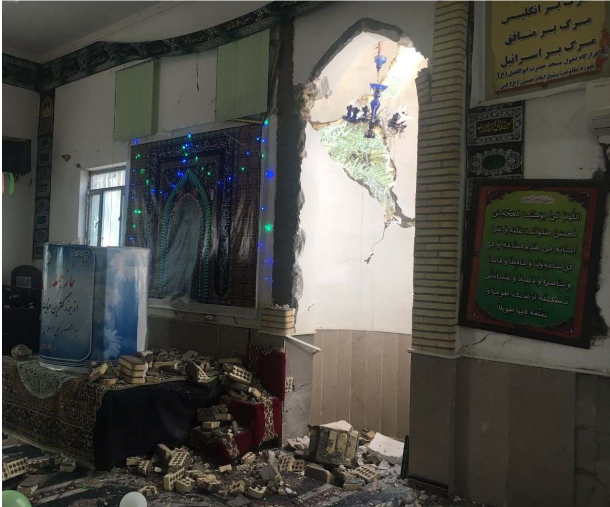
تصویر ۸۷ جذب نیروی جانبی توسط محراب و ایجاد ترک‌های برشی در آن
