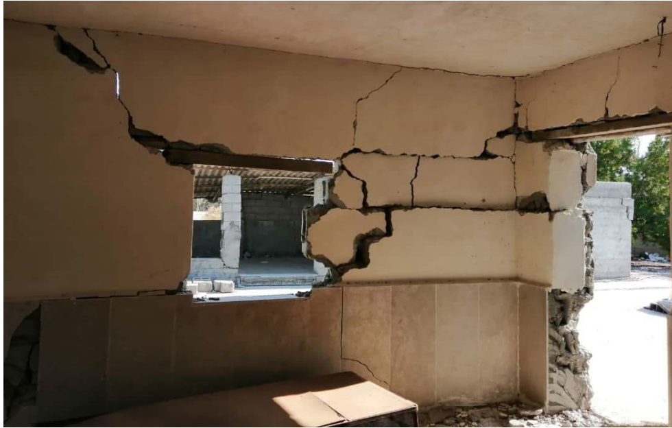
تصویر ۲۶ ترک خوردگی افقی دیوار باربر به دلیل مقاومت برشی کم ملات
