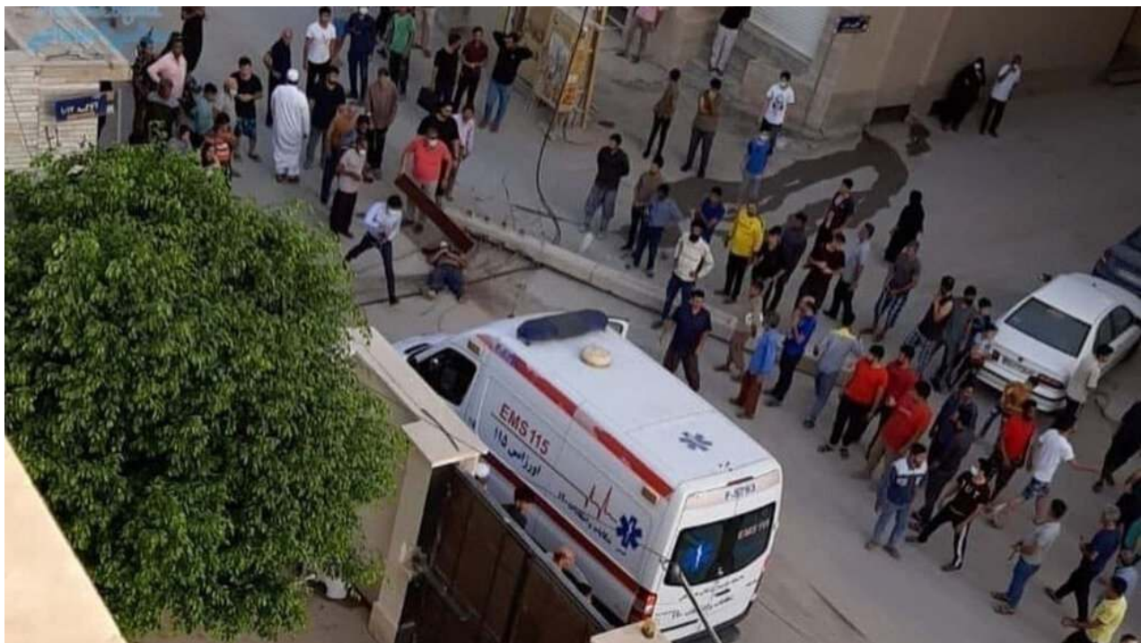
تصویر ۱۰۸ سقوط تیر برق به دلیل خوردگی بتن و کج بودن و فوت یک نفر در شهر بندرعباس
