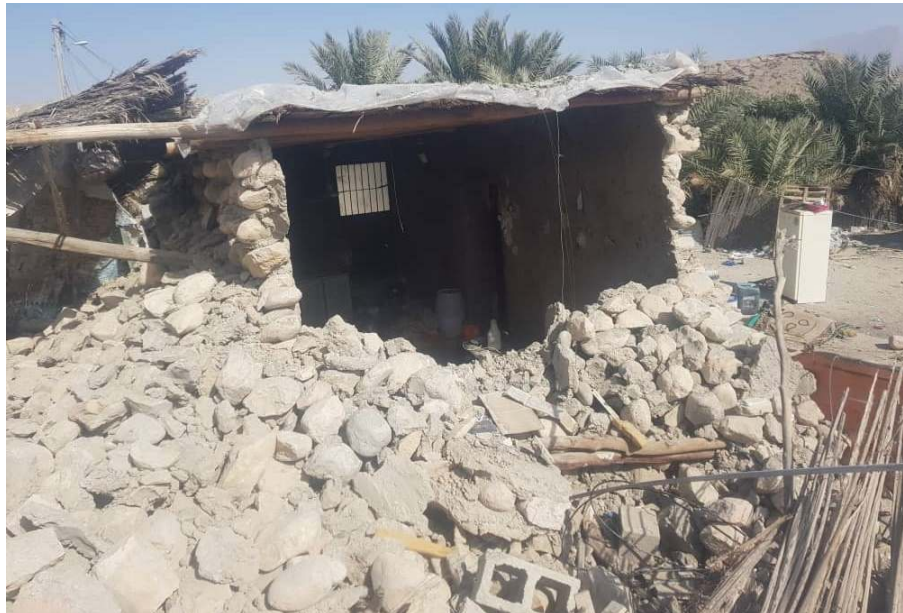
تصویر ۲۸ ریزش ساختمان‌های با دیوارهای سنگی و سقف چوبی در روستای مژرا
