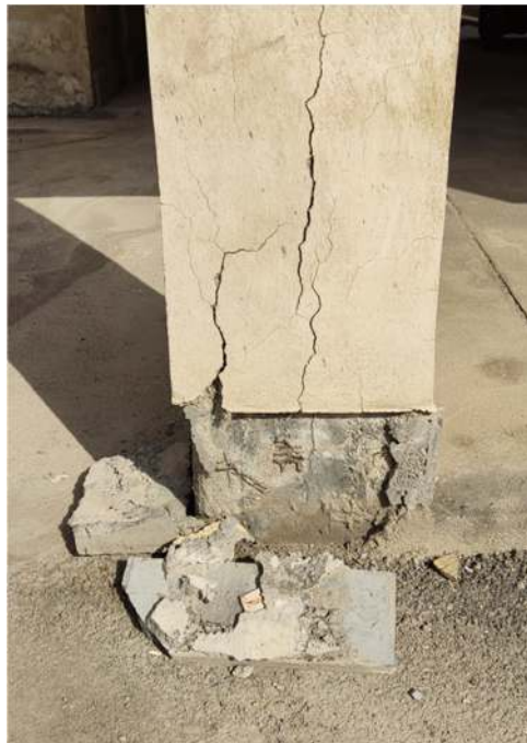
تصویر ۵۶ خوردگی ستون‌های بتنی و فونداسیون سازه به دلیل بالا بودن سطح آب زیرزمینی در بندرعباس
