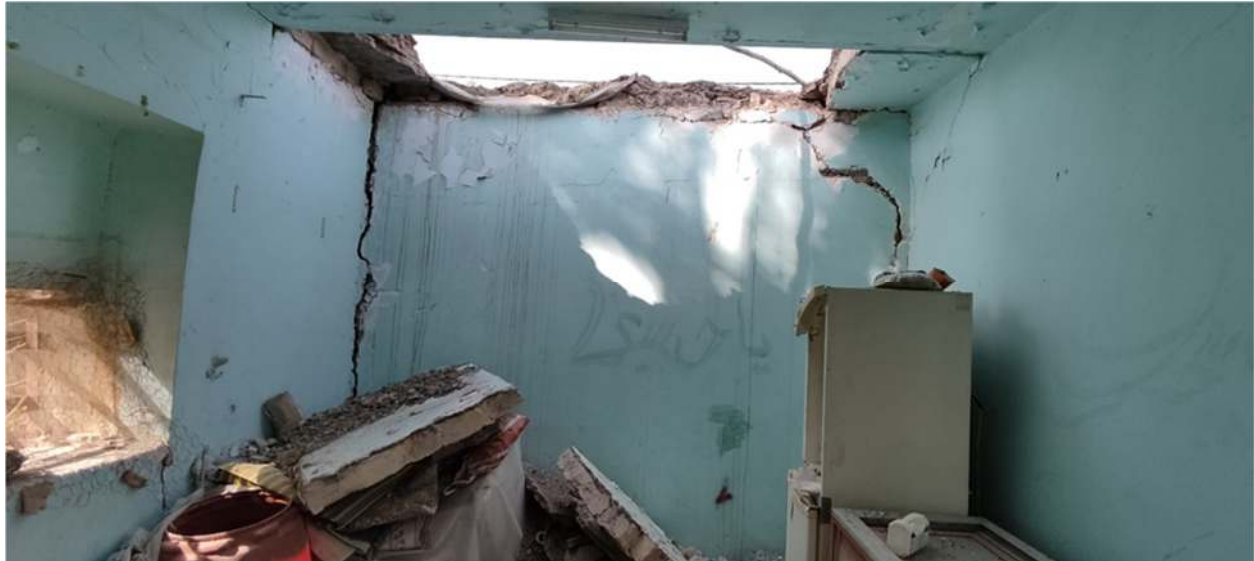
تصویر ۳۳ ریزش بخشی از سقف طاق ضربی به دلیل حرکت دیوار و عدم پیوستگی سقف با میلگردهای مهار
